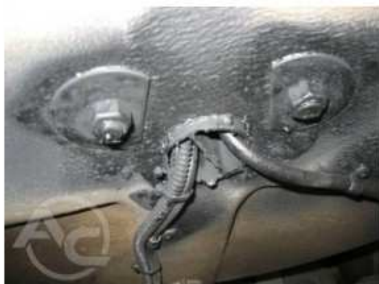
Obr. 1.3.13 Pohled na nainstalovanou nádrž ze spodku vozidla
